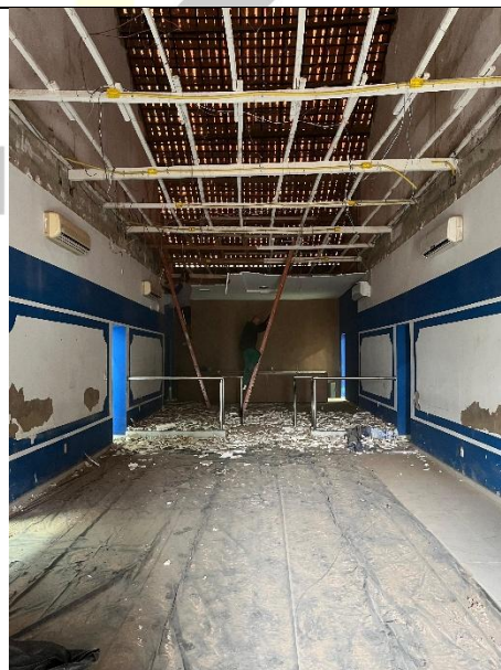
DEMOLIÇÃO DE FORRO DE GESSO
