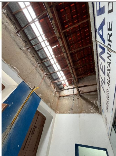
RETELHAMENTO E CALHA EM ZINCO
