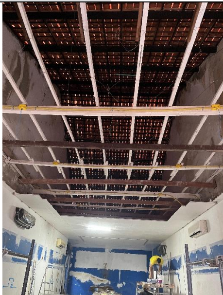
MADEIRAMENTO E EXECUÇÃO DE FORRO DE GESSO
